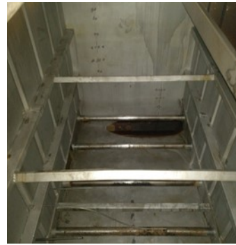
Kuva Säiliöstä puhdistuksen jälkeen
